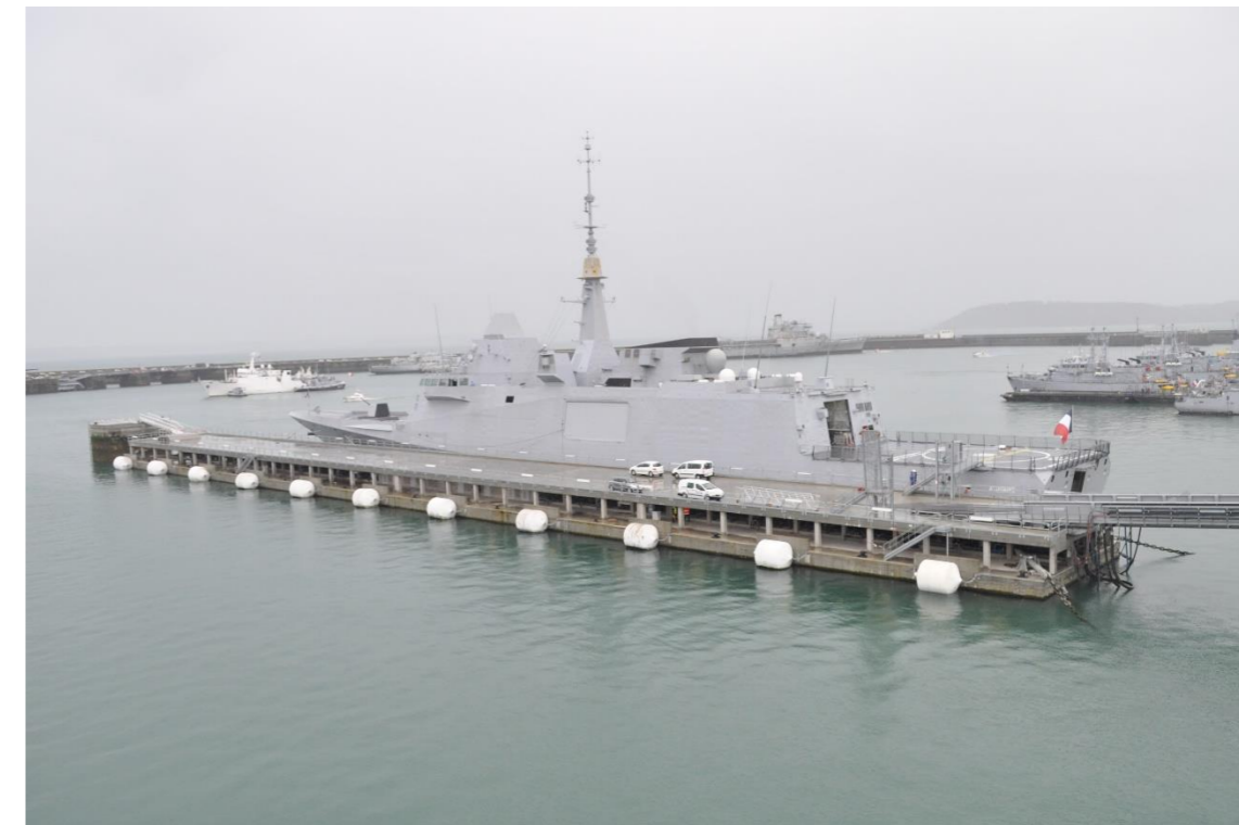
Figure 4 : Vue du ponton FREMM1
